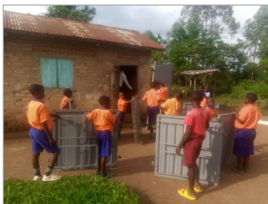
16. April 2024: Die neuen Fenster werden angeliefert
