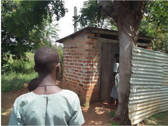
Toilettenbau in Kyakajaaka: aus alt ...
